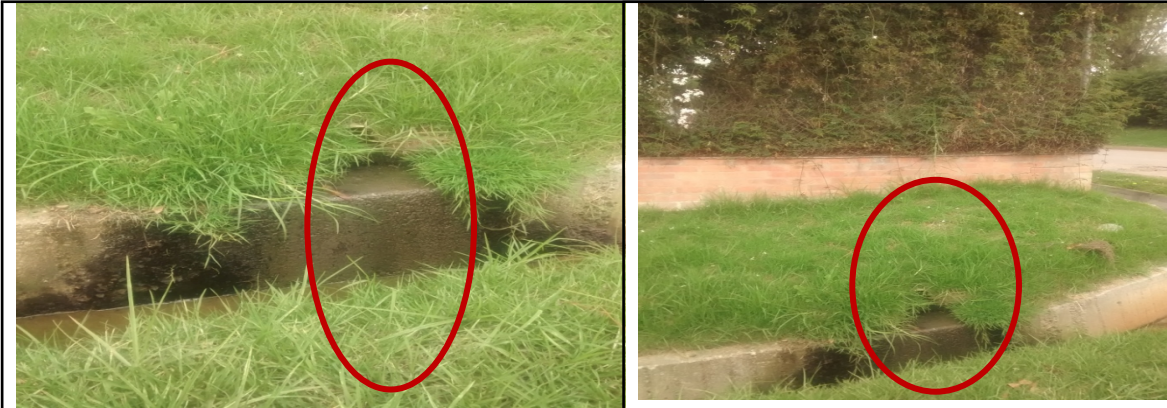
Foto No 8 y 9. Punto de descarga al canal en tierra calle 223
