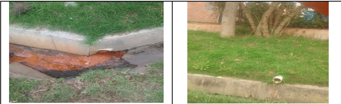
Foto No10 y 11. Tuberías de descargas de lluvias
